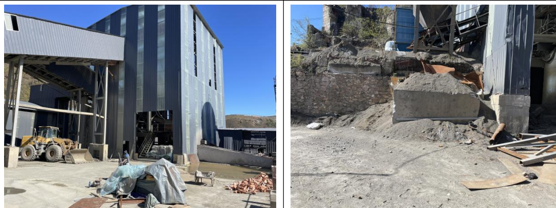
项目场地内现状情况
